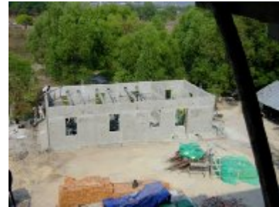
Das Haus ist schon bald fertig
