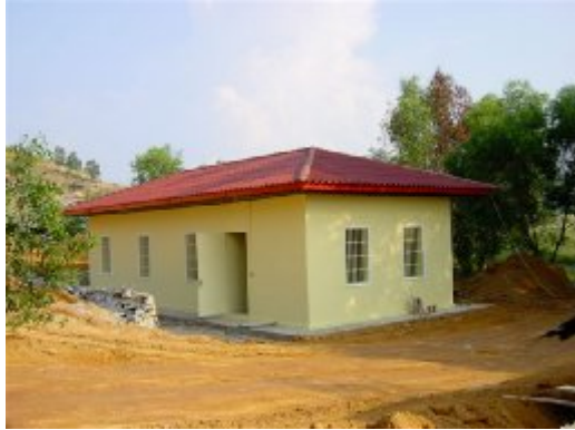
Das fertige Generatorhaus
