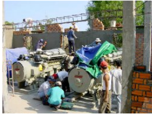
Auf der Baustelle
