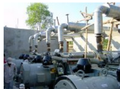
Drei Generatoren montiert
